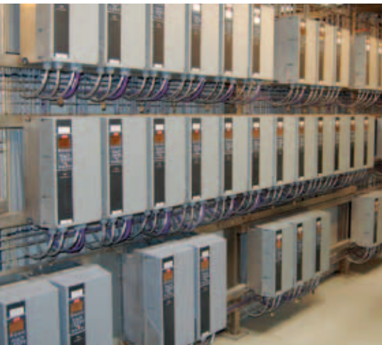
典型的变频器安装是将多个变频器全部安装在相同电源上，往往需要辅助性谐波抑制以避免谐波电压畸变。
